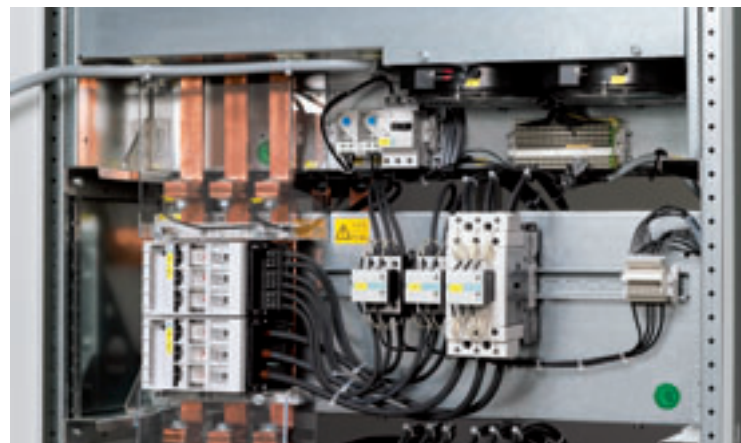
Feld zur Blindleistungskompensation 500 kvar
