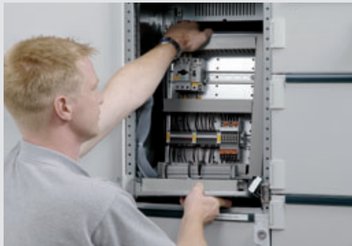
Herausnehmbarer Hilfsgeräteträger für schnelle Anpassungsarbeiten
