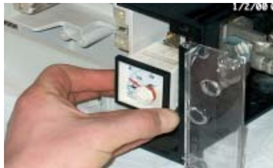
Bild 16: Herausziehen des Amperemeters
