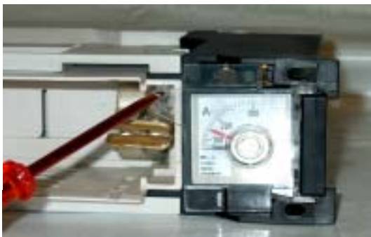
Bild 15: Öffnen der Amperemeter- abdeckung
