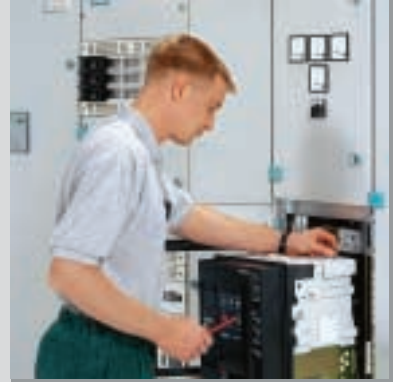
3WN in Wartungsstellung; Inspektion ohne Entnehmen des Leistungsschalters
