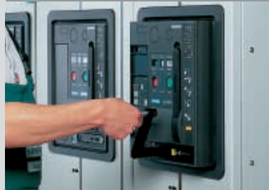
Sicheres Verfahren des Leistungsschalters bei geschlossener Tür
